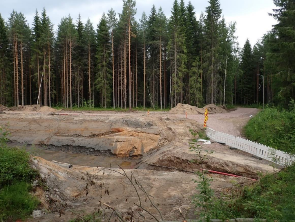
Vanhan kirkon muistokyltti on sijainnut Kirkkosaaren eteläosassa, kevyen liikenteen väylän itäpuolella (kuvan oikeassa kulmassa). Paikalla oli tehty tienparannustöitä laajoine kaivantoineen, joista ei havaittu jälkiä kirkkorakennuksesta tai hautauksista. Itään.
