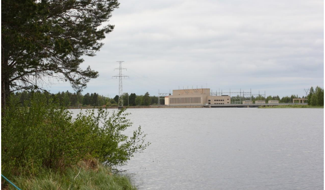
Kuva 20. Valtakunnallisesti merkittävään Pyhäkosken voimalaitoksen rakennettuun kulttuuriympäristöön kuuluva voimalaitosrakennus. Näkymä Leppiniemen asuinalueeseen kuuluvan vierasmajan rantsaunalta.
