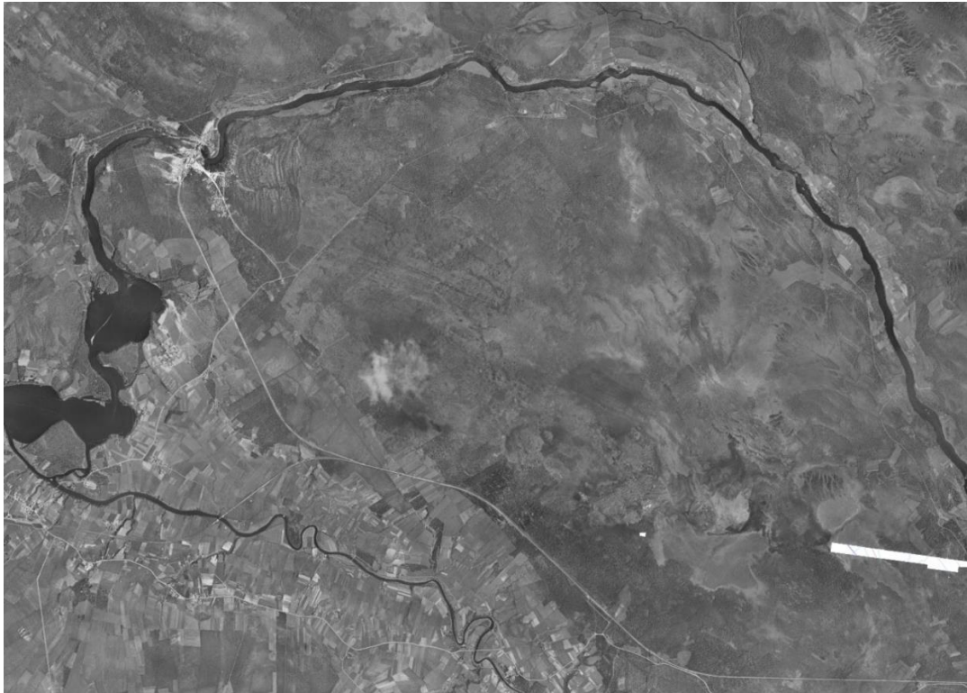
Kuva 3. Ilmakuvapari. Ilmakuva vuodelta 1946 (Paikkatietoikkuna/MLL ilmakuva-arkisto 10.10.2024). Kuvasta erottuu patoamaton jokiuoma. Pyhänselän voimalaitoksen rakentaminen on kuitenkin jo alkanut, mikä näkyy kuvassa laajoina maansiirtotöinä voimala-alueen läheisyydessä.
