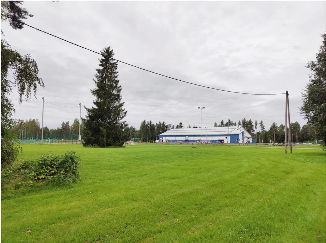
Kuva 12. Muhoksen jäähalli ympäristöineen kaakosta katsottuna (Lukkaroinen Arkkitehdit Oy, 08/2023).
