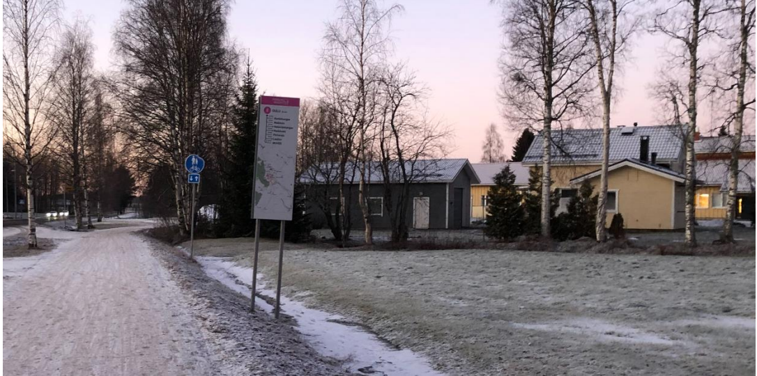
Kuva 5. ja 6. Suunnittelualueella sijaitseva omakotitalo on laajennettu rintamamiestalo. Samalla kiinteistöllä sijaitsee kookas autotallirakennus (2024).
