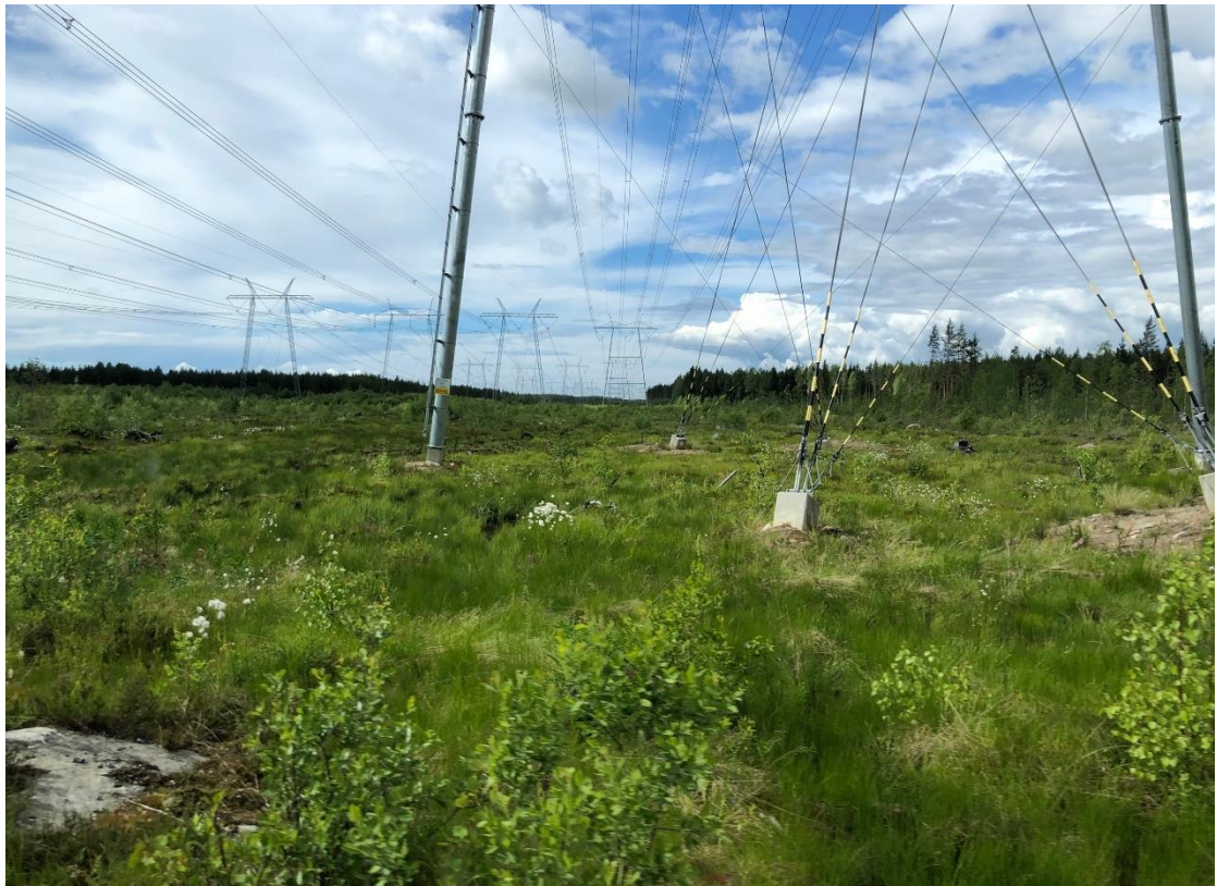
Kuva 15. Pyhänselkä-Nuojua voimajohdon johtoaueka Pyhänsivuntieltä.
