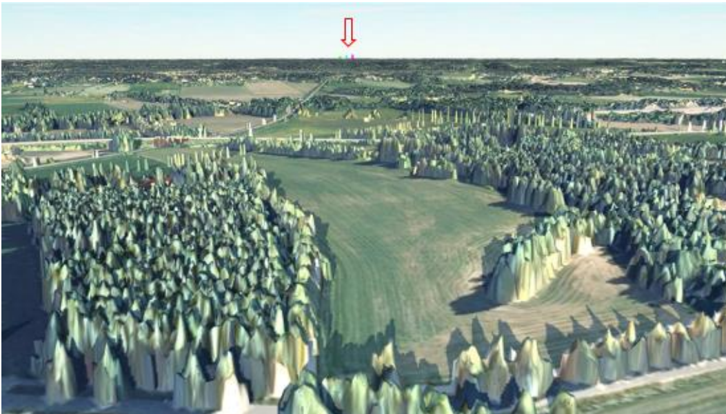
Kuva 81. Osayleiskaavoitettavan alueen keskiosiin sijoitetut 40, 50 ja 60 m korkeat tornirakenteet viistoilmakuvassa. Tornit erottuvat puustoa korkeampina elementteinä, kun niitä tarkastellaan lintuperspektiivissä. Käytännössä maisemaa ei kuitenkaan ole mahdollista tarkastella tältä korkeudelta – esimerkiksi alueen asukkaat näkevät maiseman keskimäärin 1,5 metrin korkeudelta. (Kuva Lukkaroinen Arkkitehdit Oy 2024.)
