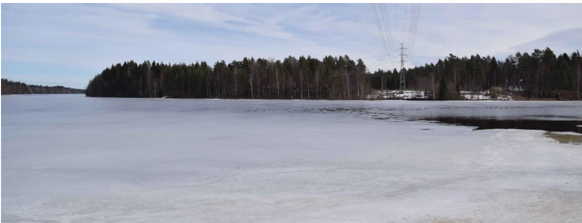
Kuva 38. Näkymä Pyhäkosken voimalaitoksen patosillalta itään suunnittelualueen suuntaan.
